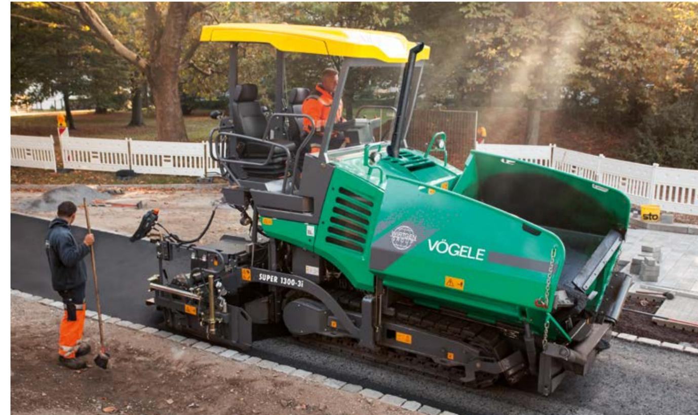
Wenn die Beschickung auf engen Baustellen einmal schwierig ist, garantiert das große Volumen des Aufnahmebehälters beim SUPER 1300-3i, dass die Bohle trotzdem optimal mit Mischgut versorgt werden kann.
